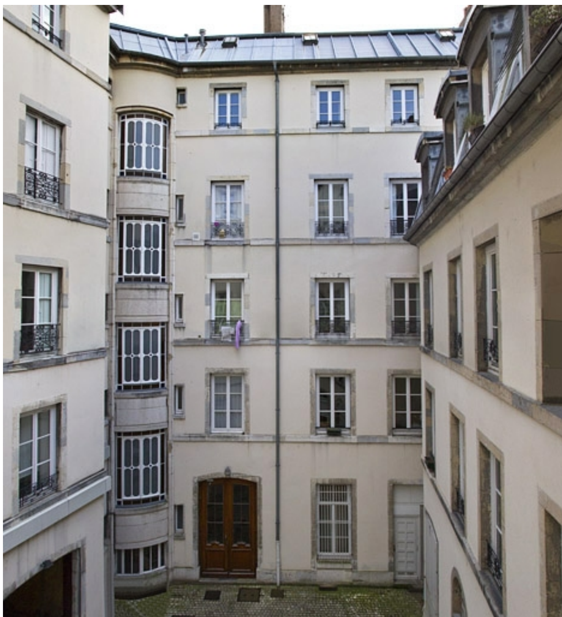
Logis principal, façade postérieure, côté rue Morand.
