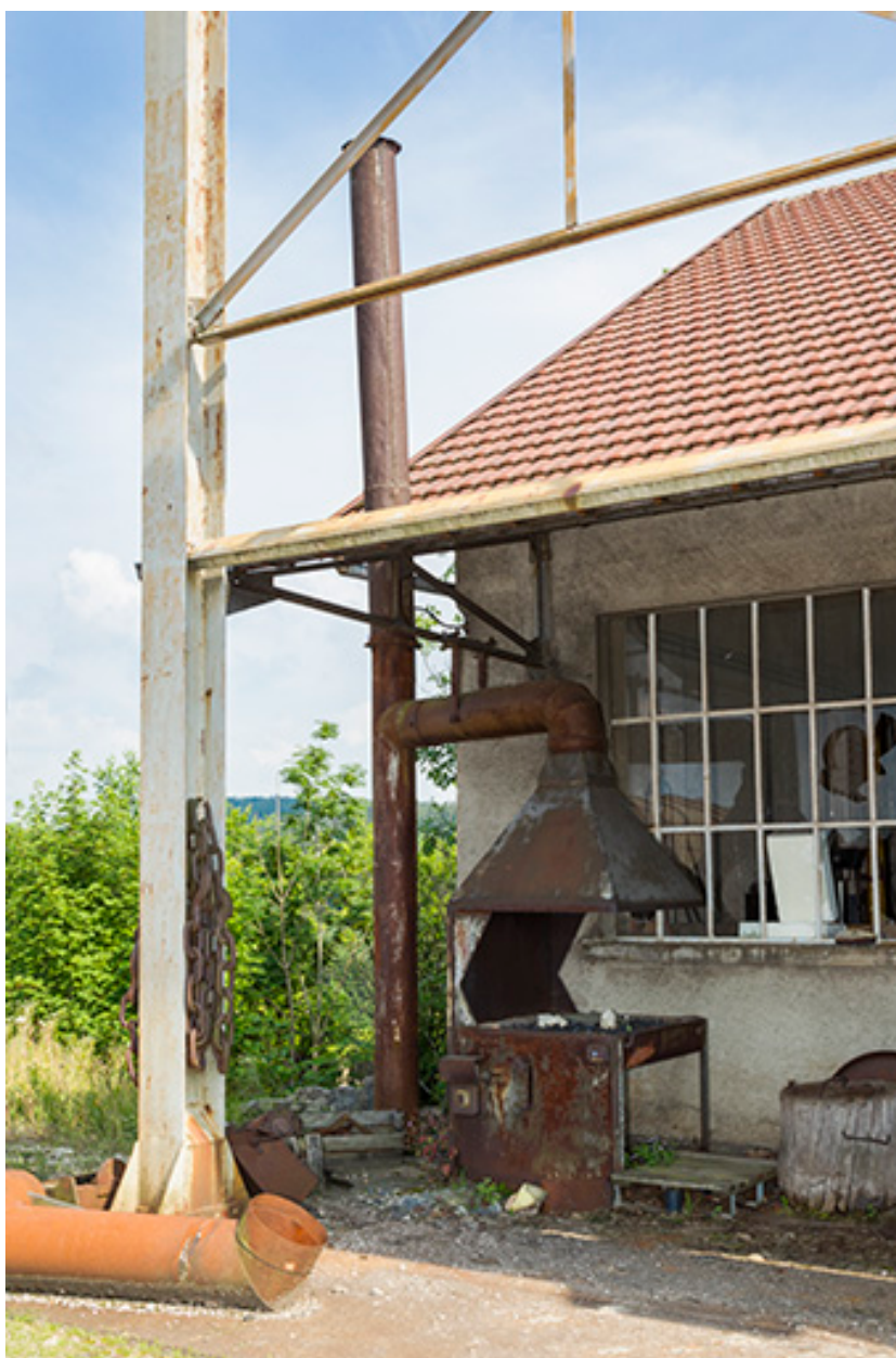
Site rue du Contremont : forge extérieure.
