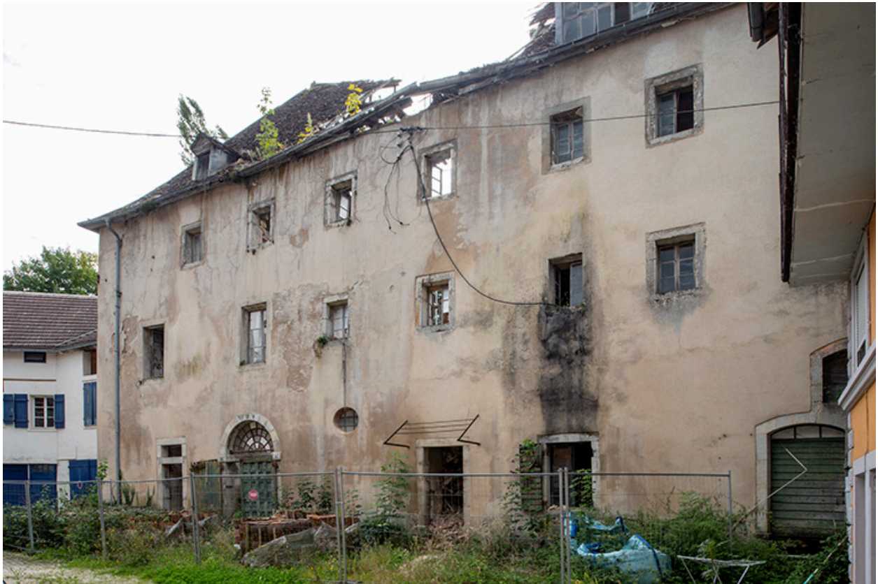
Façade nord du grand bâtiment conventuel.
