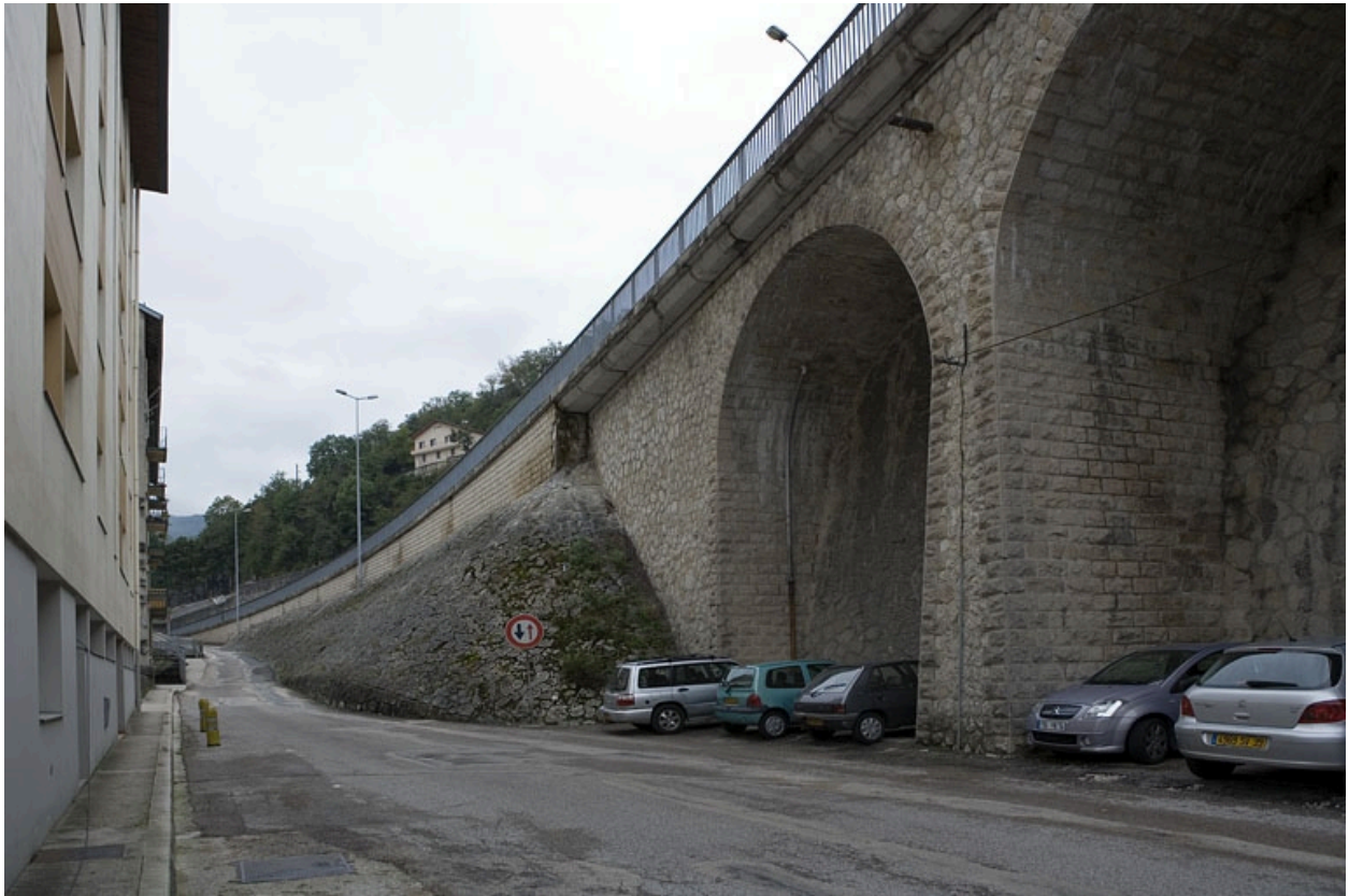
Jonction entre le perré et la première arcade.
