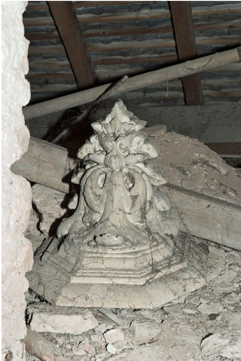
Vue d'ensemble d'une console.
