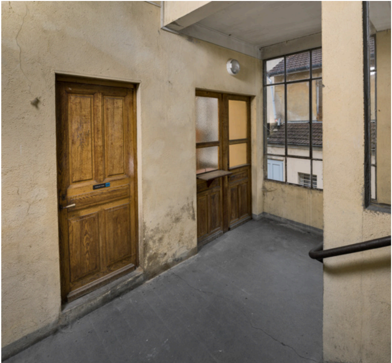
Escalier principal, repos : porte des sanitaires et guichet.
