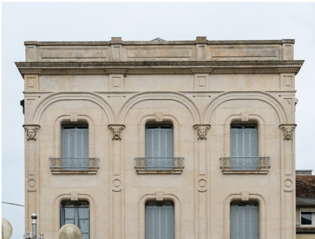
Façade antérieure : décor sculpté en partie haute.
