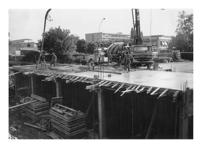
[Construction du laboratoire de métrologie, rez-de-chaussée : coulage du plancher en béton], 1981.
