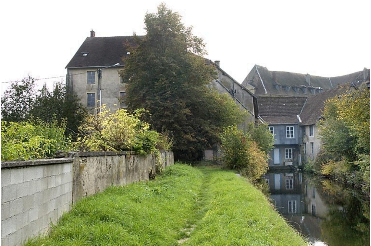
Façade postérieure depuis l'amont du bief.
