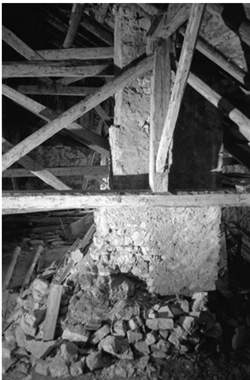
Intérieur : charpente et cheminée.
