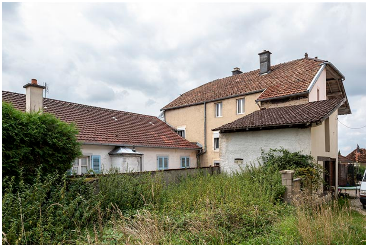
Bâtiment au 2 rue du Chêne : façade postérieure.
