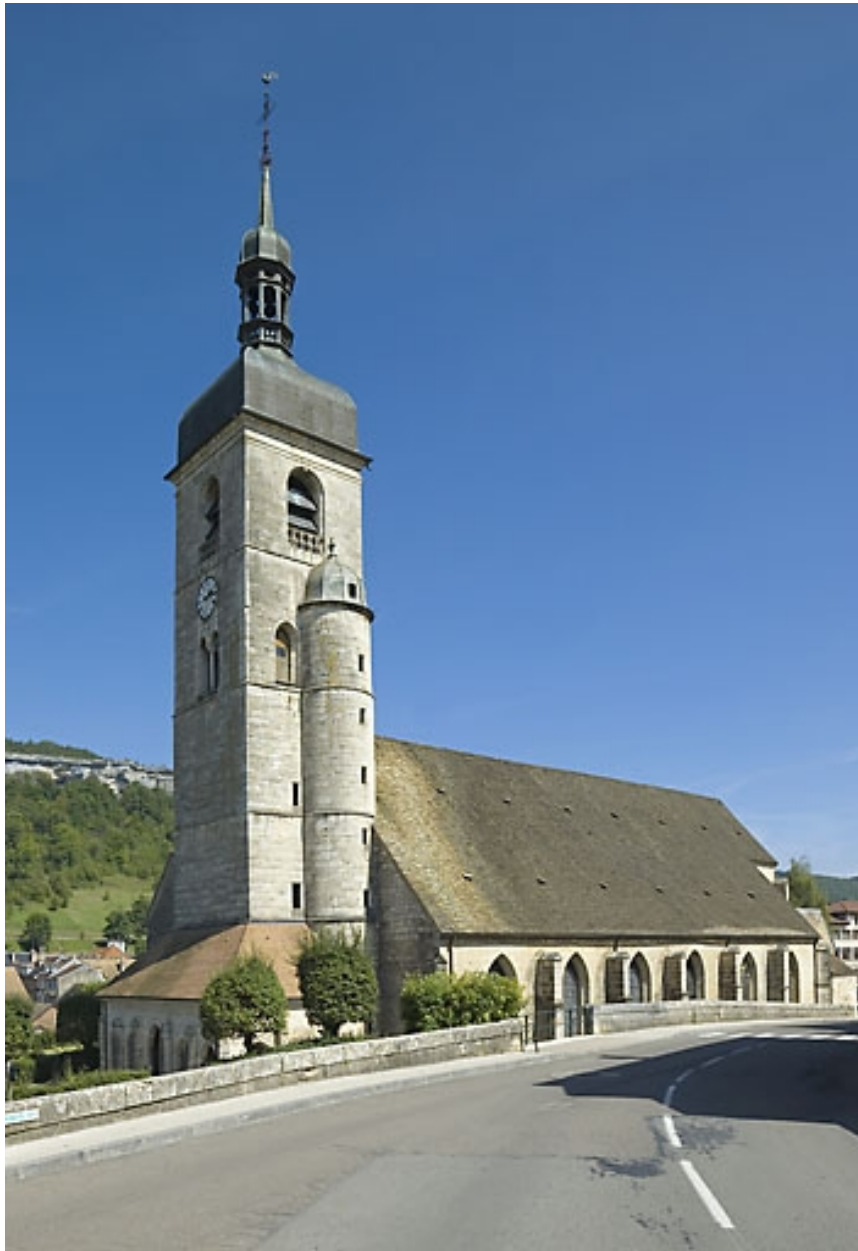
Vue de la tour-clocher.
