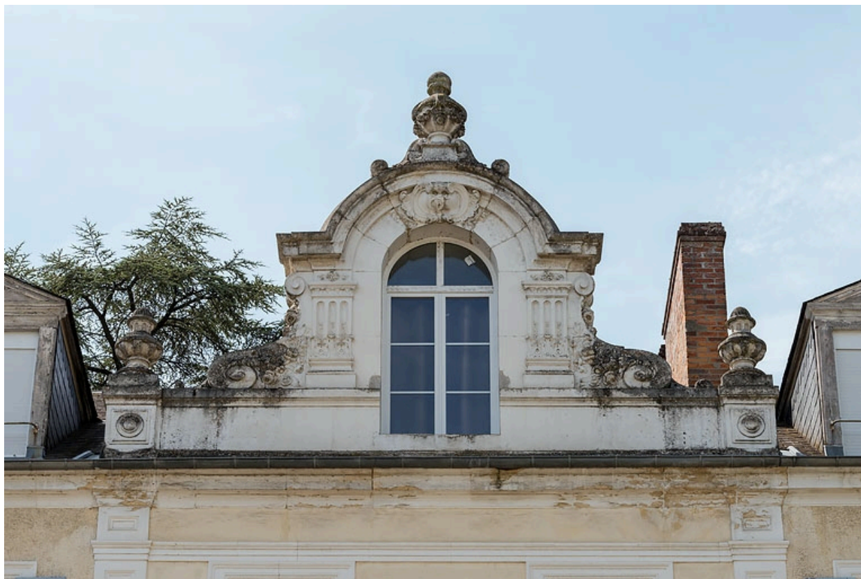
Lucarne centrale de la façade nord du corps principal, vue en 2020.
