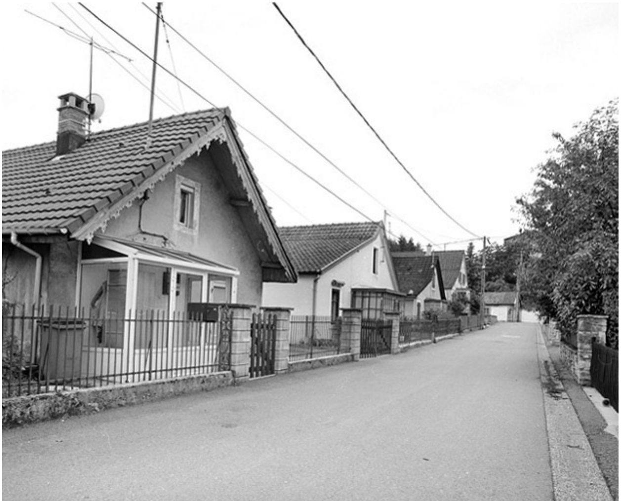
Alignement de maisons rue du Temple.
