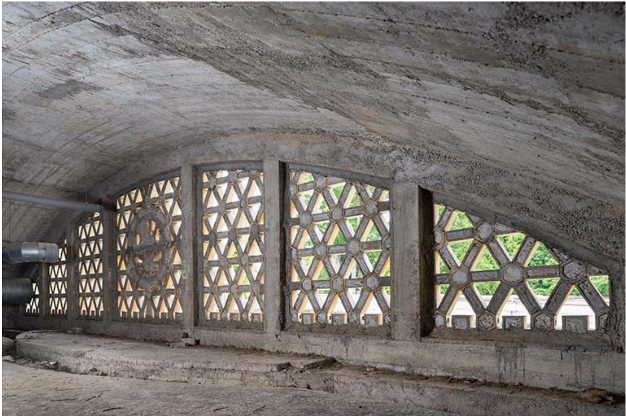
Fronton de la façade nord, vue intérieure.
