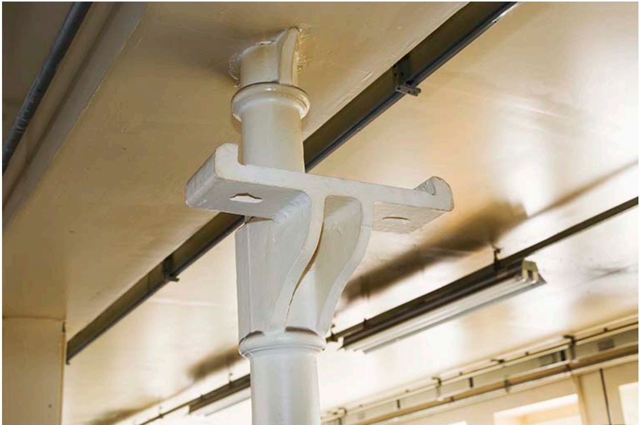
Usine, rez-de-chaussée : support des transmissions sur le poteau de soutènement.
