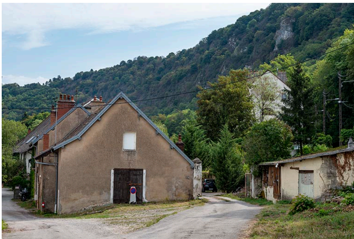
Ecurie et remises depuis l'ouest.
