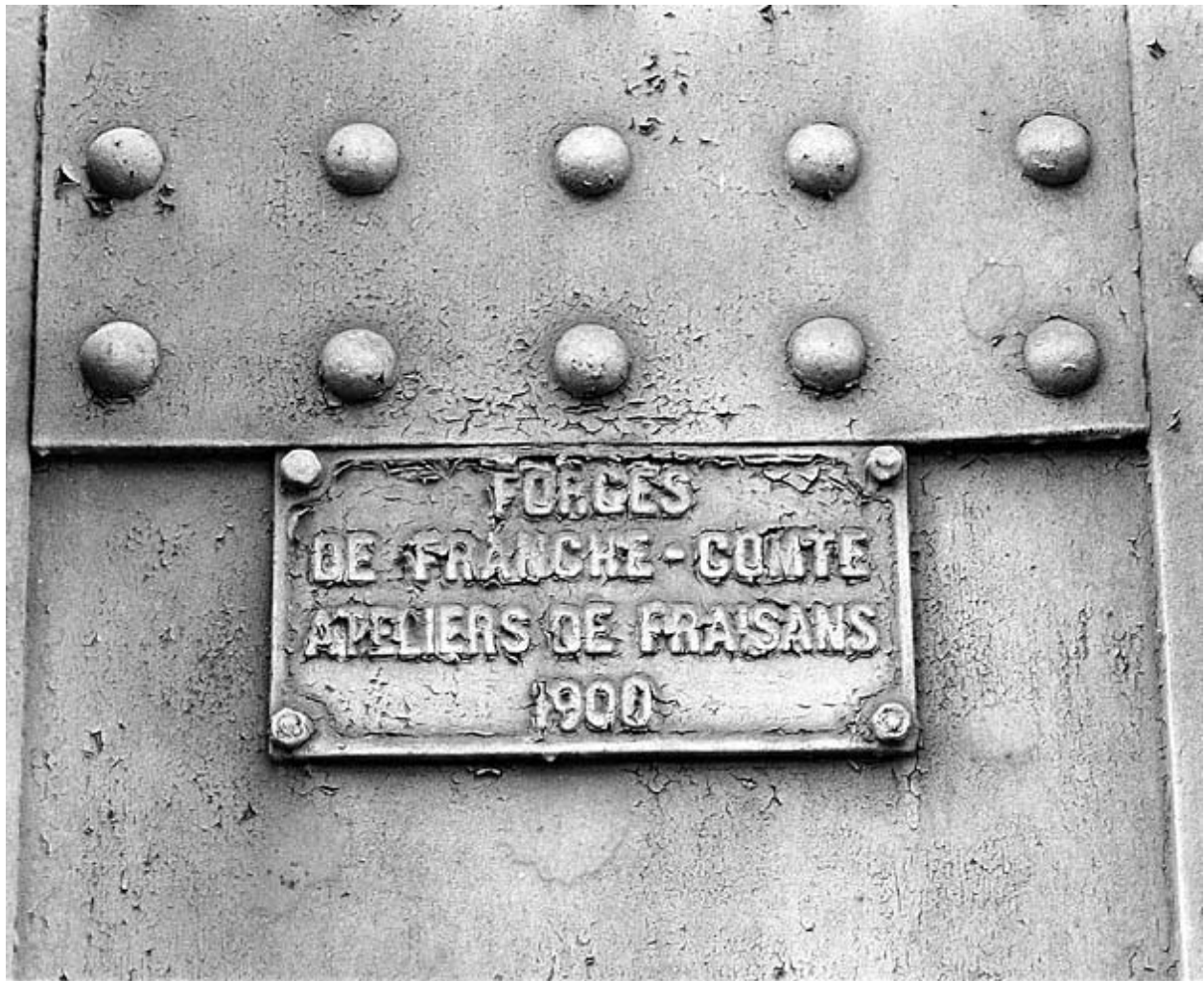
Plaque du constructeur et date. Cette plaque est fixée sur le pont, côté La Cluse.
