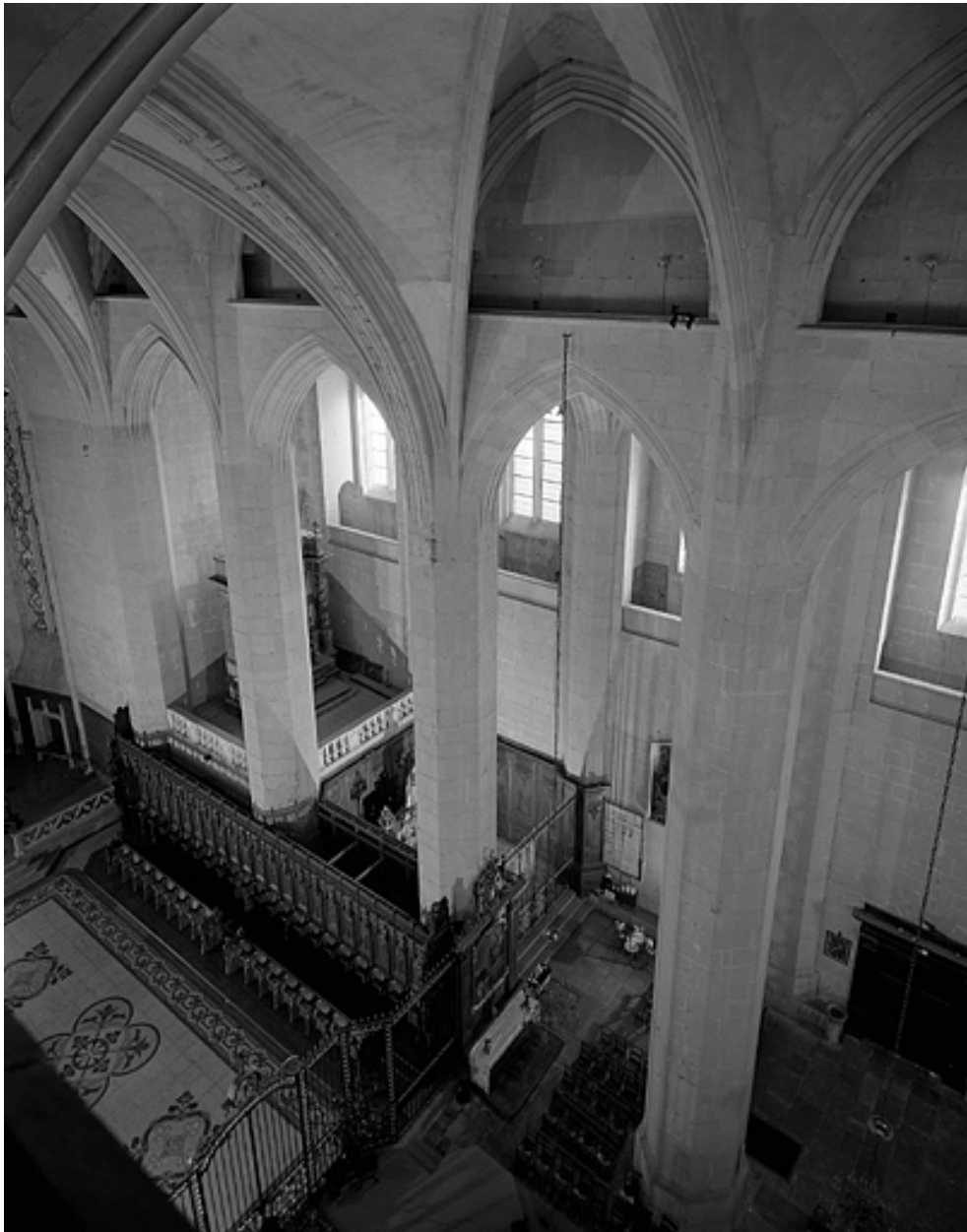
Elévation sud des travées orientales de la nef depuis la coursière haute.
