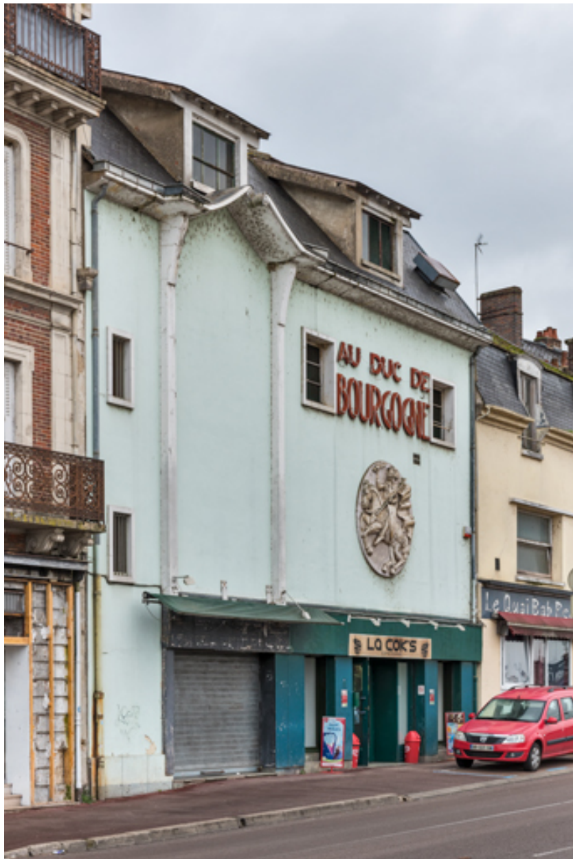
Joigny, 10 quai du Maréchal Leclerc : ancien cinéma Au Duc de Bourgogne. Façade antérieure, de trois quarts gauche.
