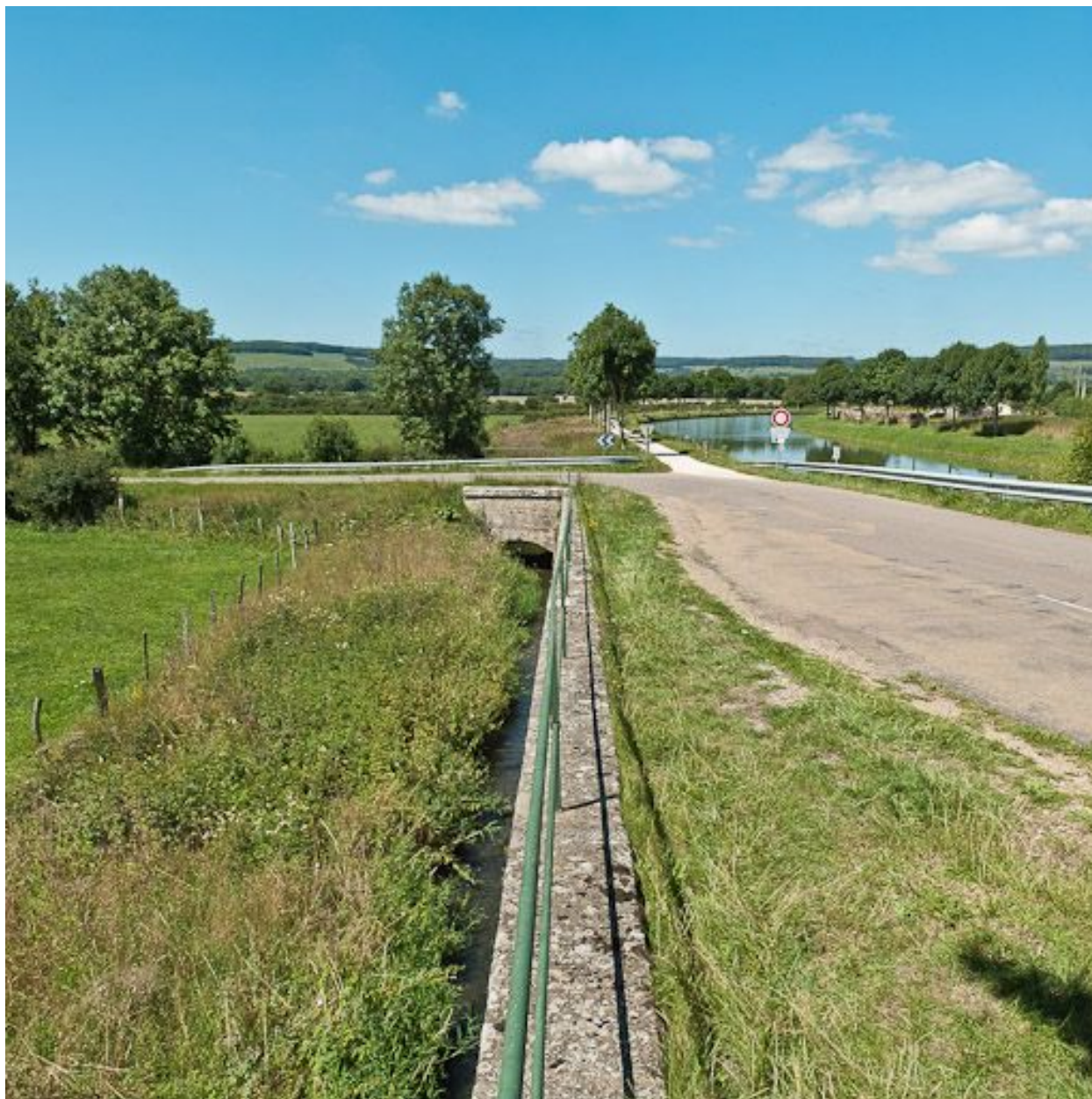
Vue du pont sur rigole.
