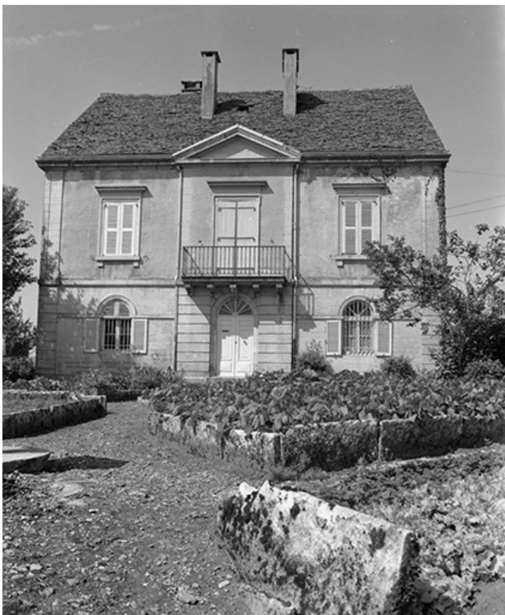
Façade antérieure et jardin.
