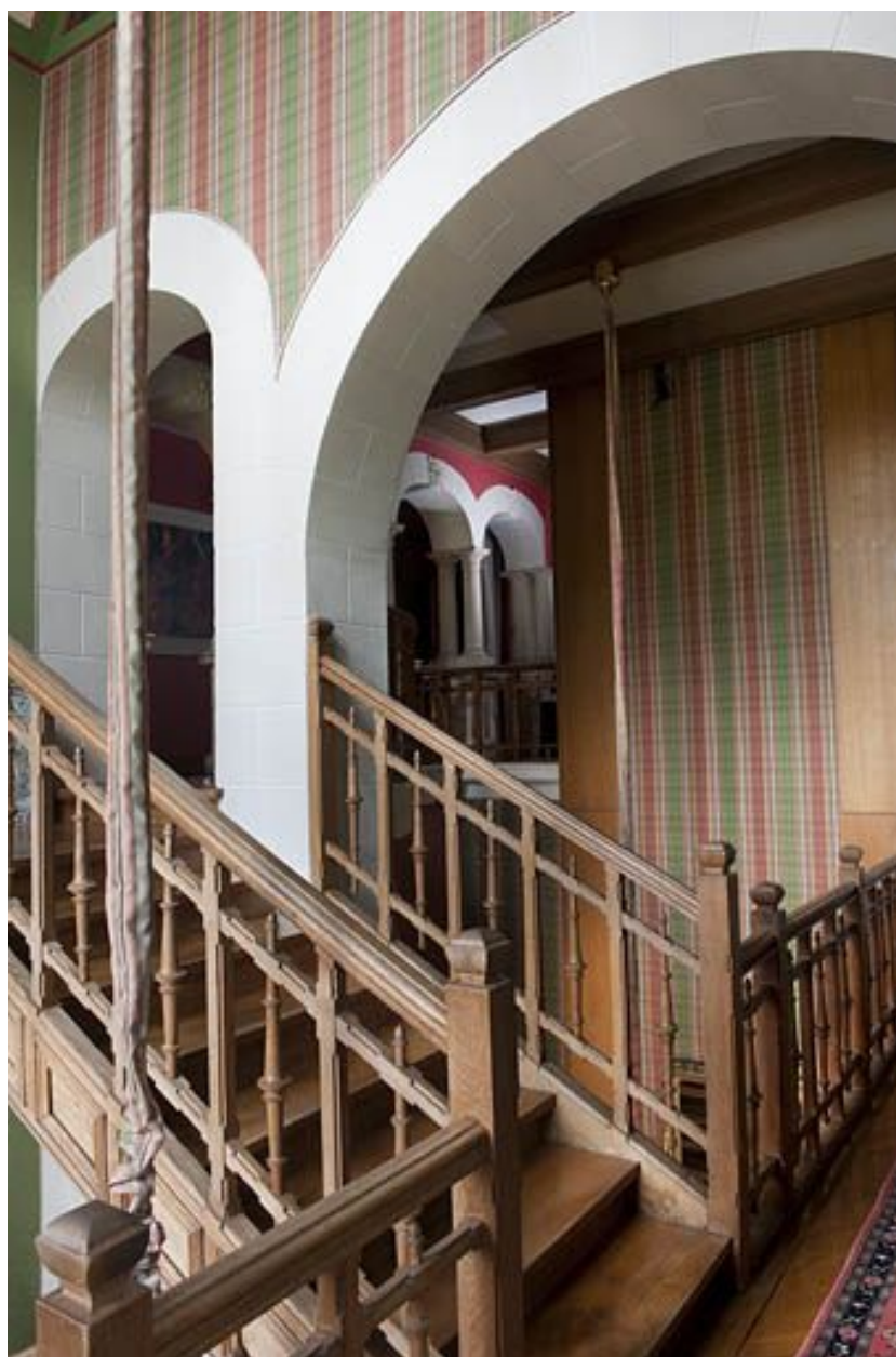
Entresol. Accès au premier étage.
