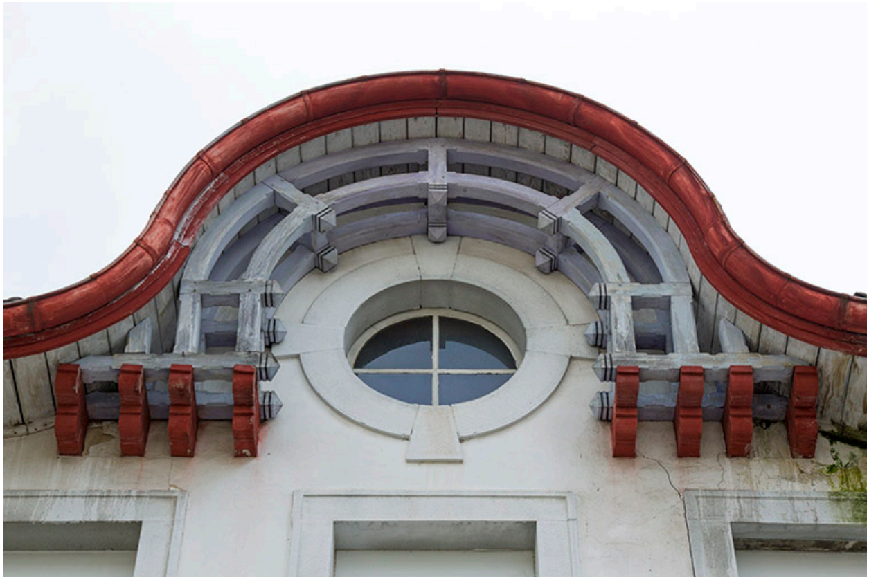
Façade antérieure : oculus vu en contre-plongée.
