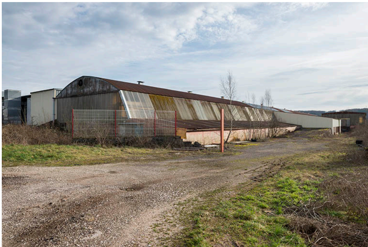
L'atelier de fabrication des panneaux.
