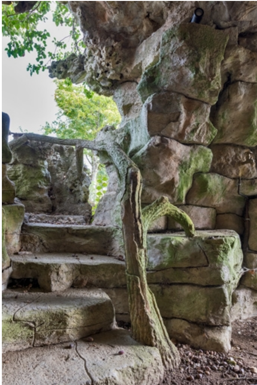
Grotte : départ de la rampe d'escalier.
