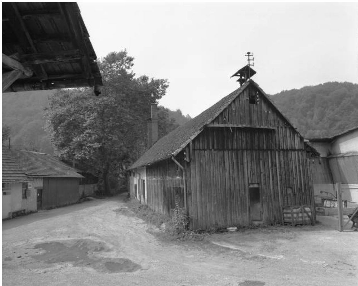
Pignon de l'atelier de menuiserie en 1981.
