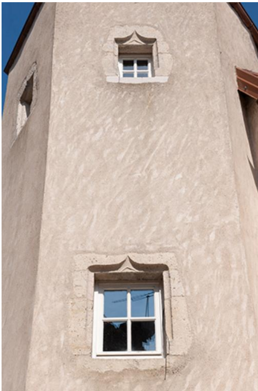
Les baies de la tour d'escalier
