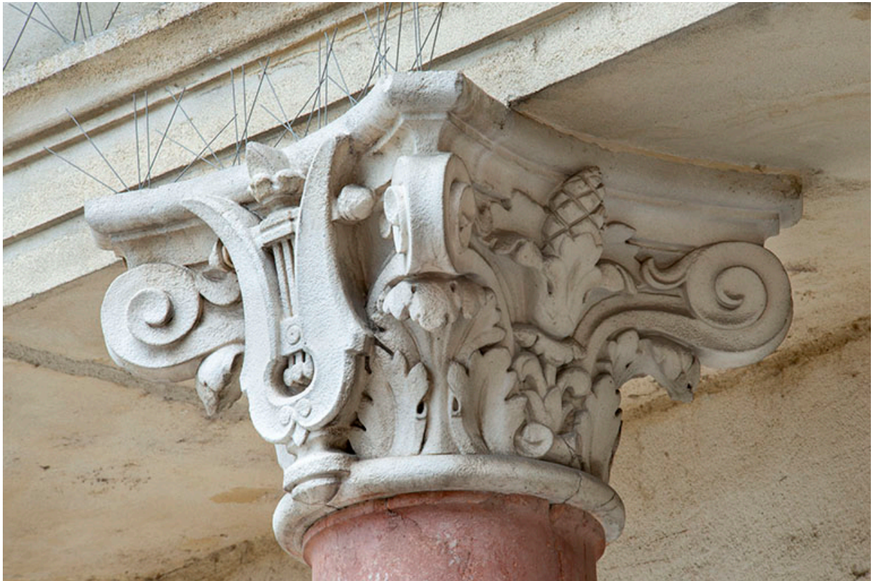
Bâtiment d'entrée, façade antérieure : chapiteau d'une colonne du 1er étage.
