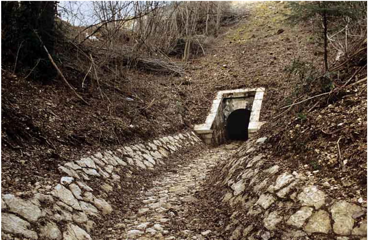
Aqueduc : tête aval et rigole (cadrage horizontal).
