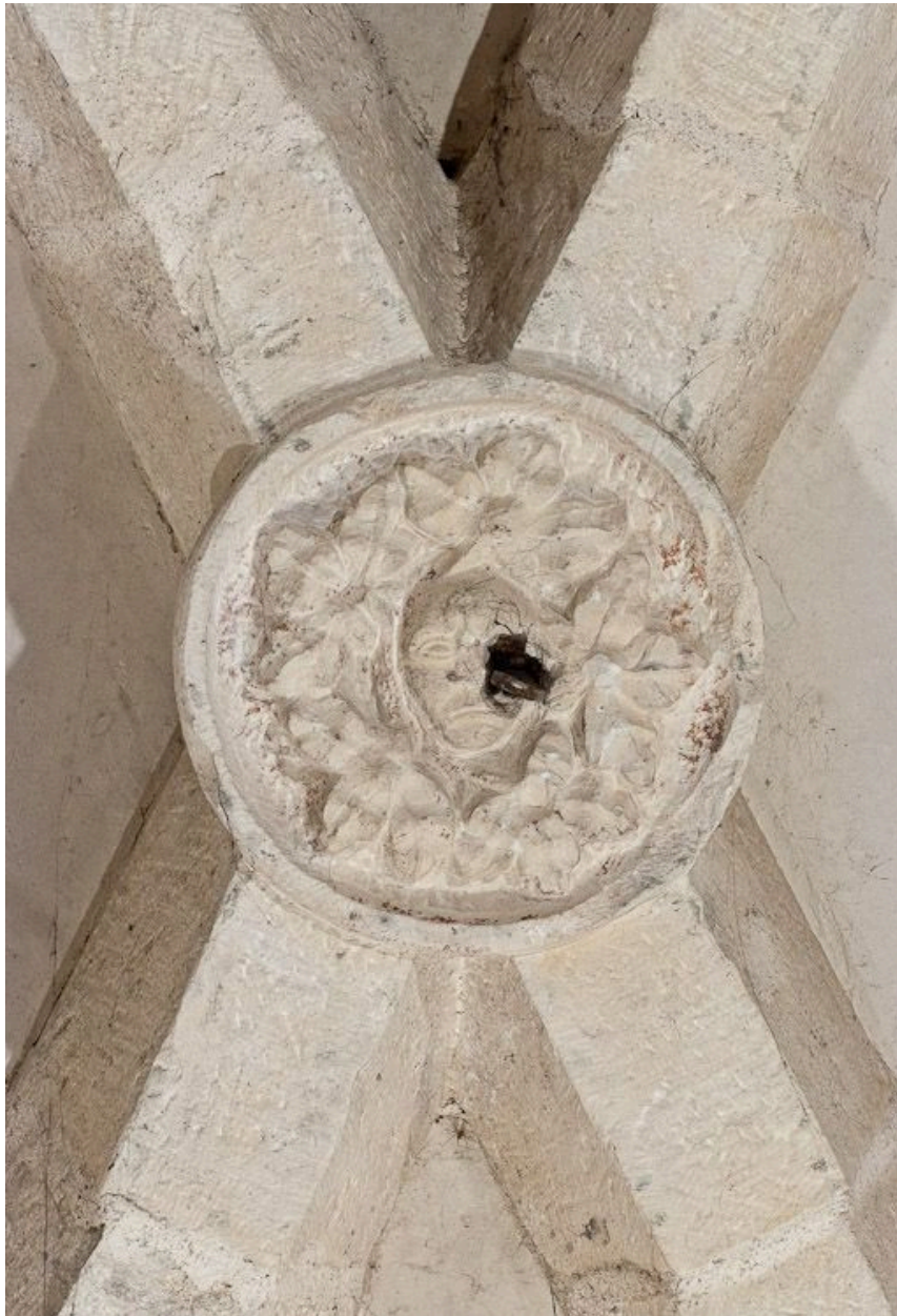
Clef de voûte de la troisième travée du bas-côté droit.
