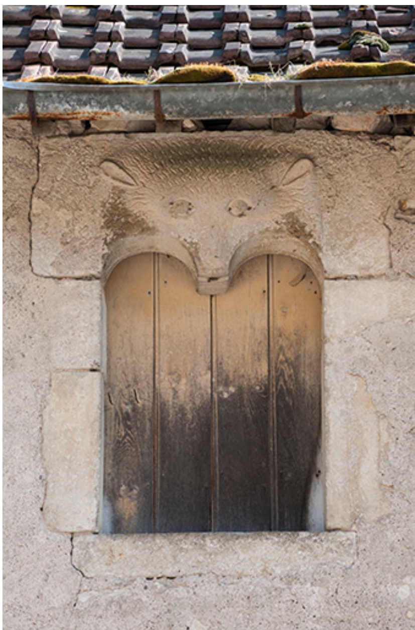
Détail d'une fenêtre du premier étage.
