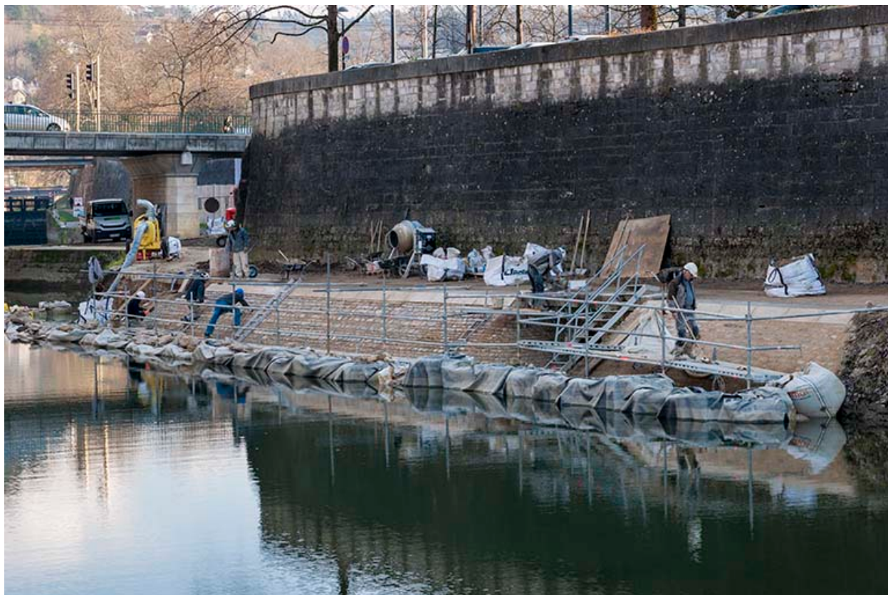
Réfection du perré du chemin de halage en aval du moulin Saint-Paul : vue d'ensemble depuis l'aval.
