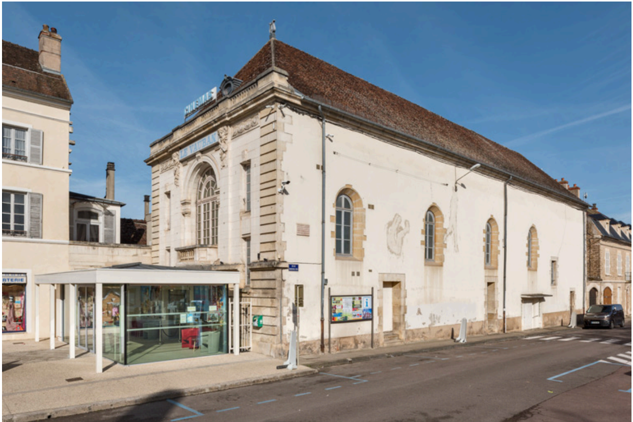
Façades antérieure et latérale droite.
