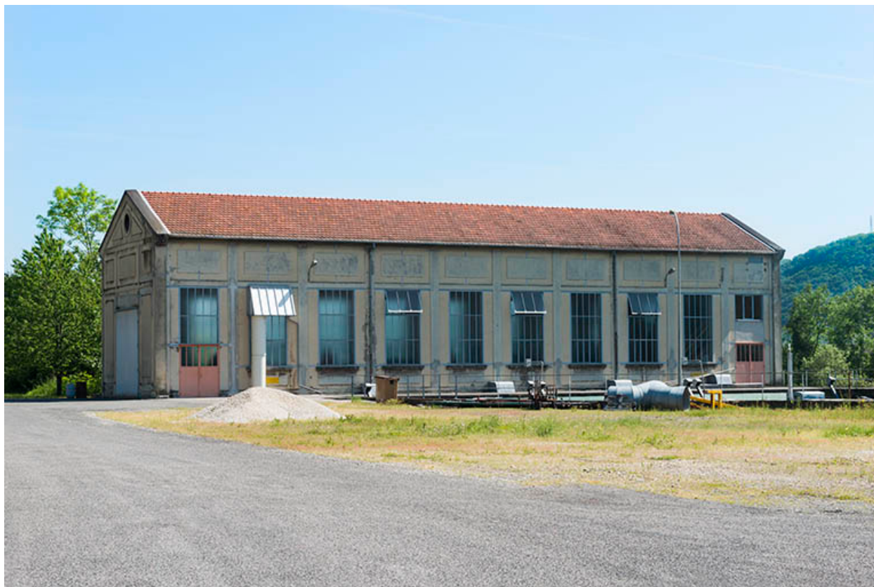
Façade sud de la centrale hydroélectrique.
