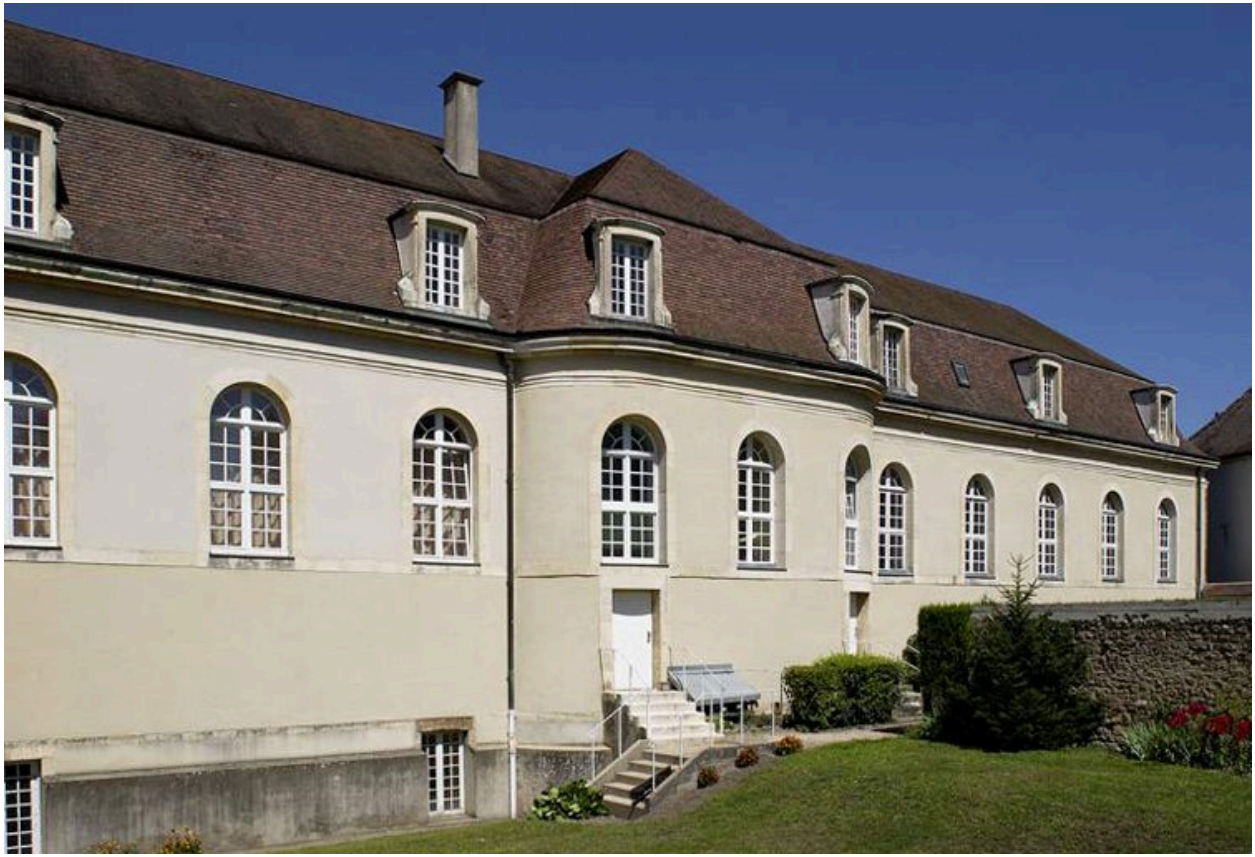
Aile gauche dite fondation Arnault : élévation postérieure.
