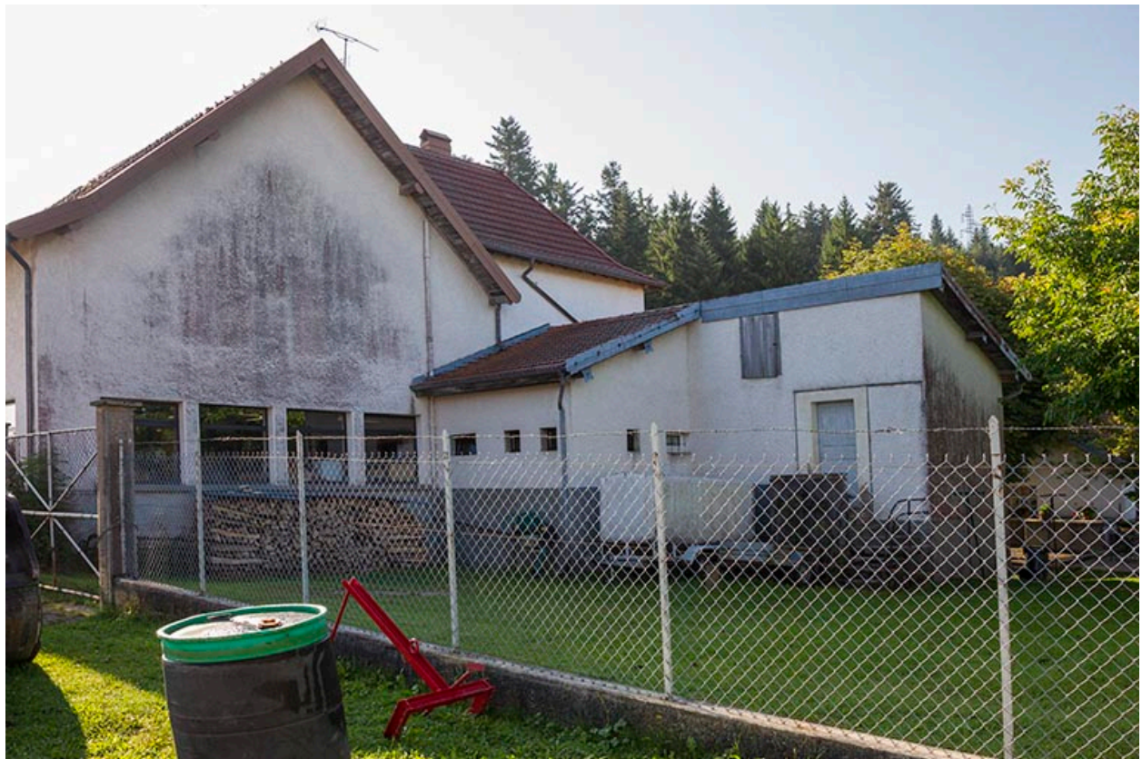
Atelier de fabrication (façade postérieure) et dépendance.
