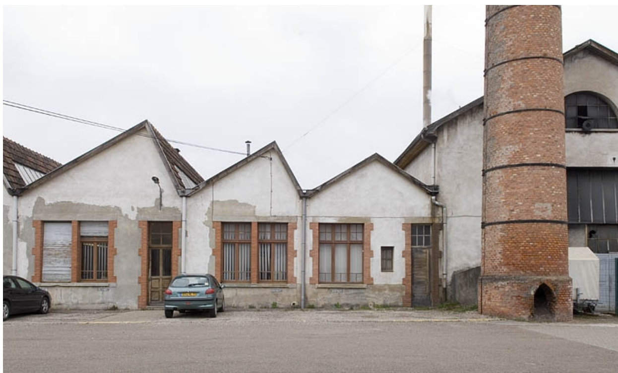
Façade est : bureaux, cheminée et chaufferie.
