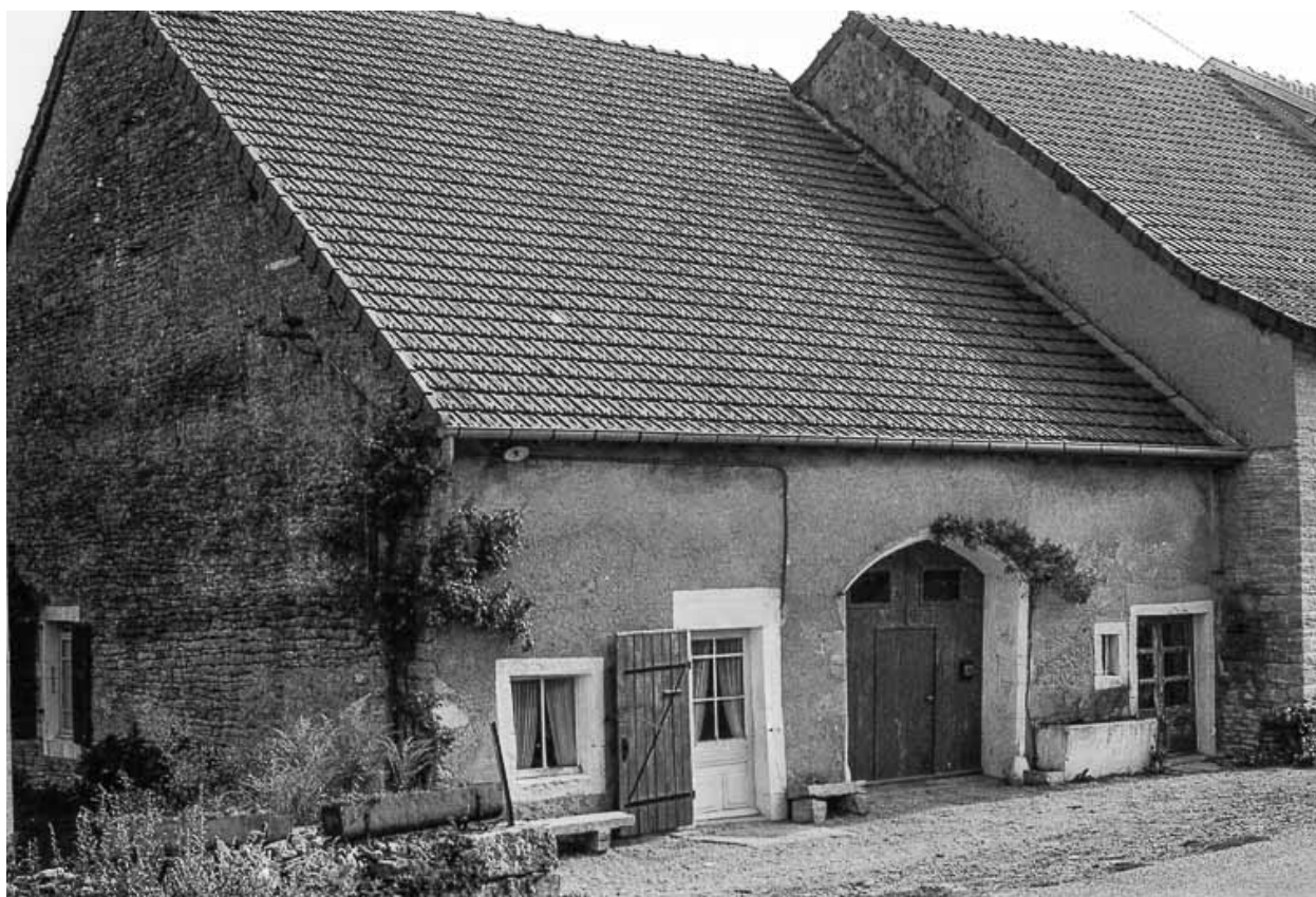
Ferme cadastrée A3 170 : façade antérieure.
