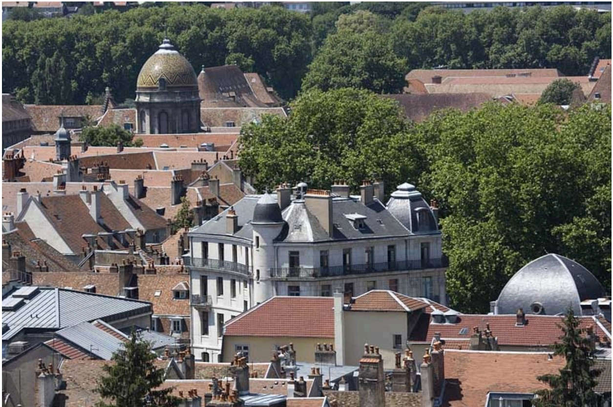
Vue d'ensemble éloignée.
