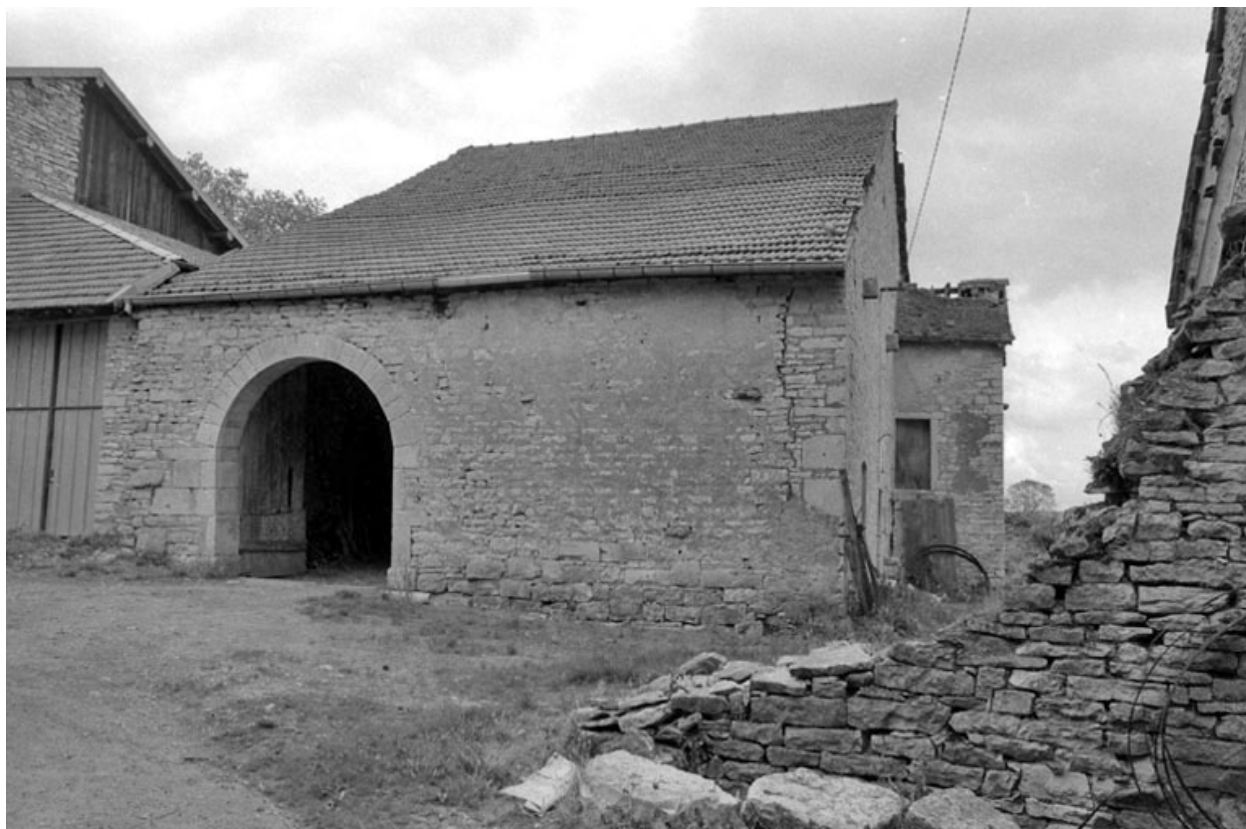
Façade latérale gauche sur rue.
