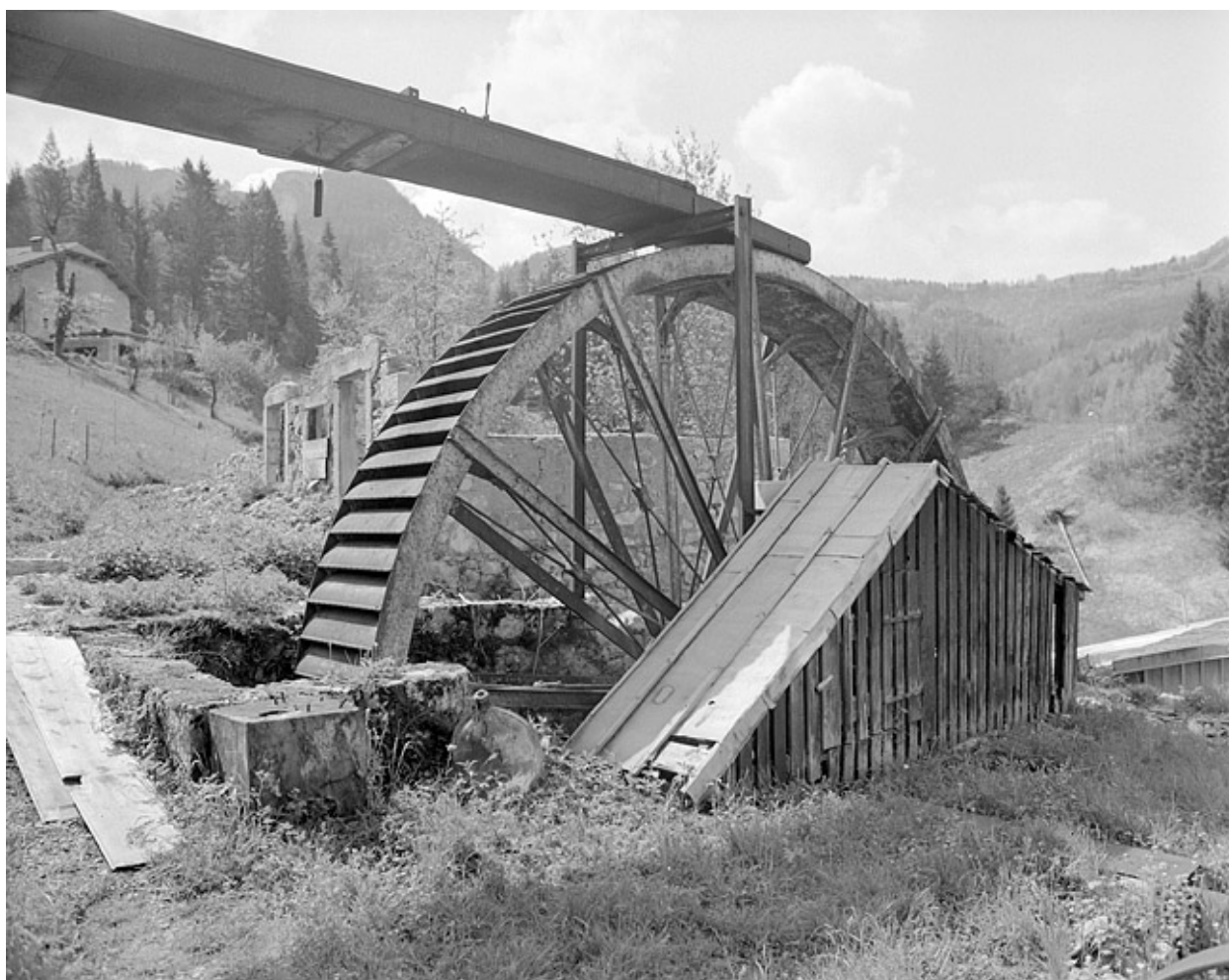
Roue hydraulique et abri du renvoi d'angles.
