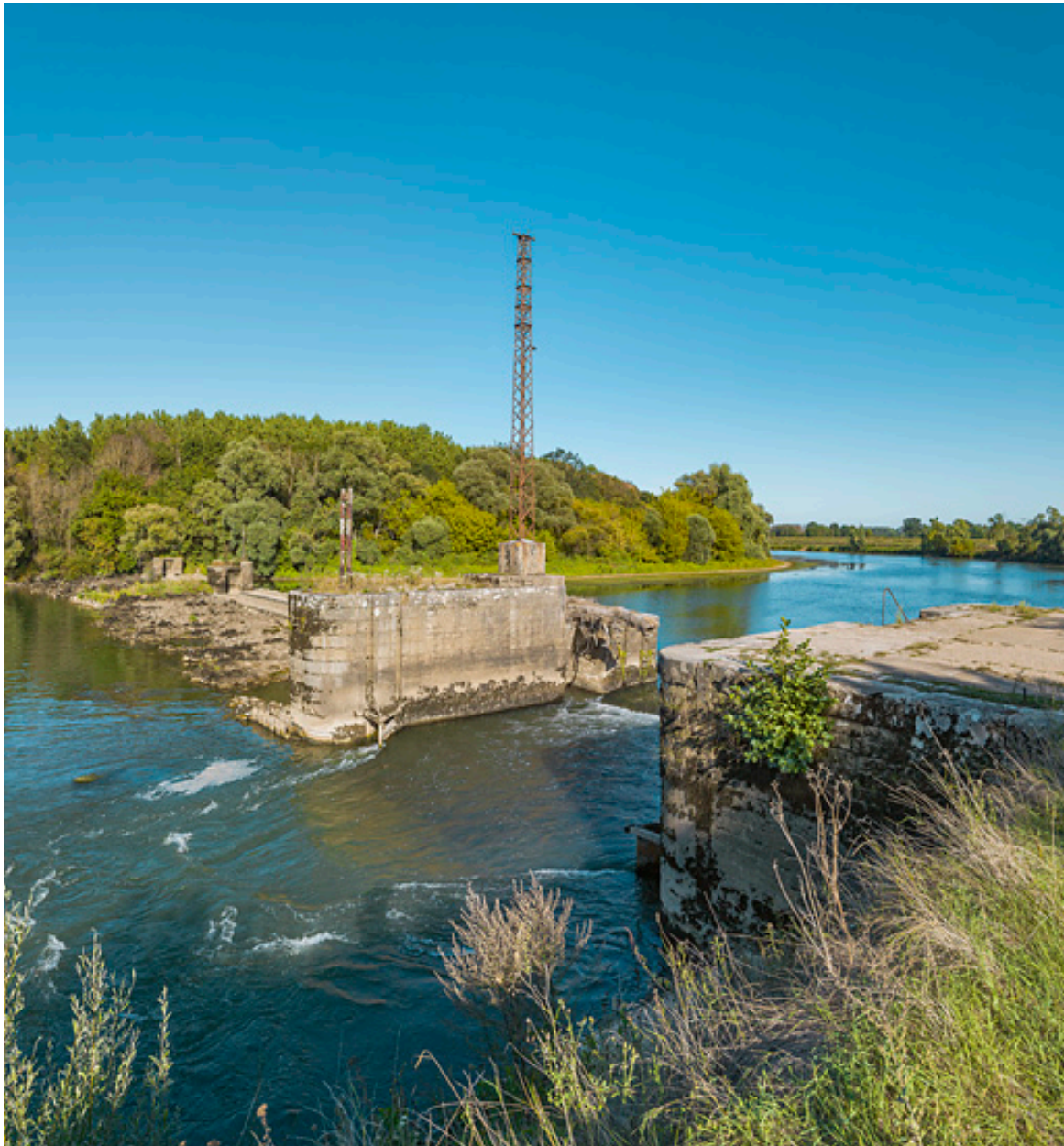
Vue d'ensemble du barrage en 2019 : au premier plan, l'ancien pertuis.
