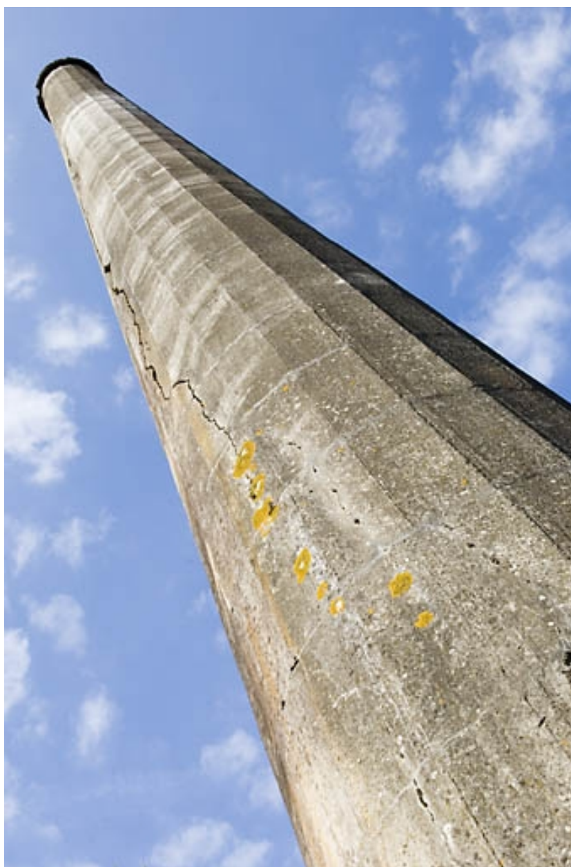
Cheminée vue en contre-plongée (2).
