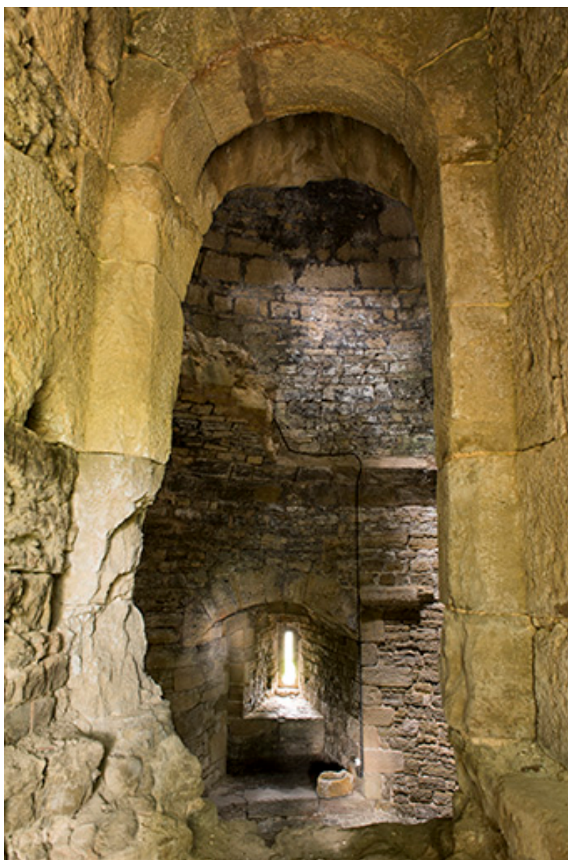
La tour ouest. Vue intérieure depuis l'entrée.
