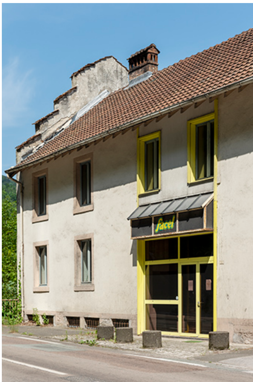
Bureau, façade antérieure : entrée.
