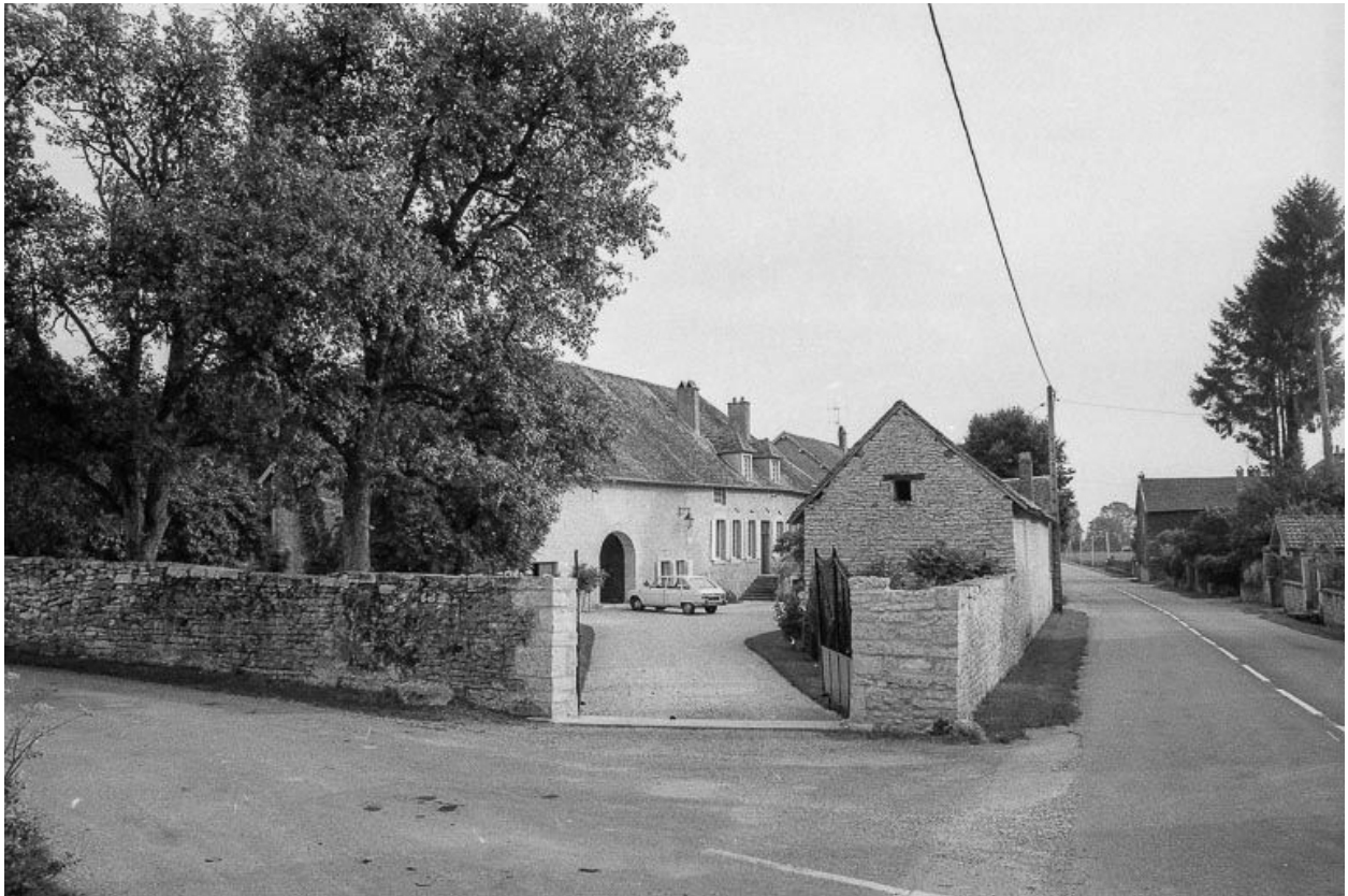
Vue d'ensemble depuis l'entrée route de Chaux.
