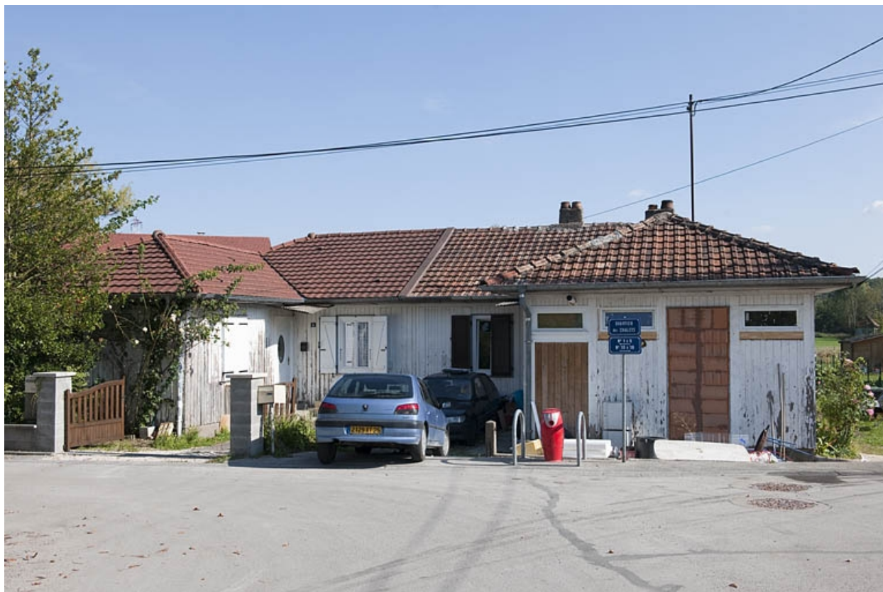
Maison jumelée vue de face.
