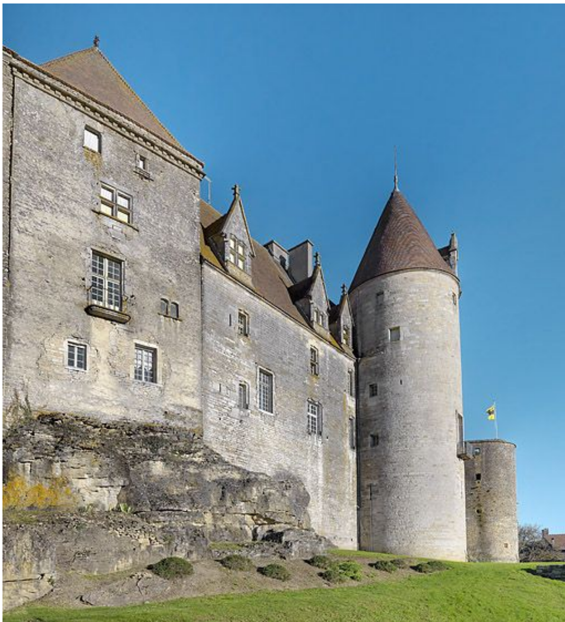
Vue du château de Châteauneuf, tour de la face sud des remparts.
