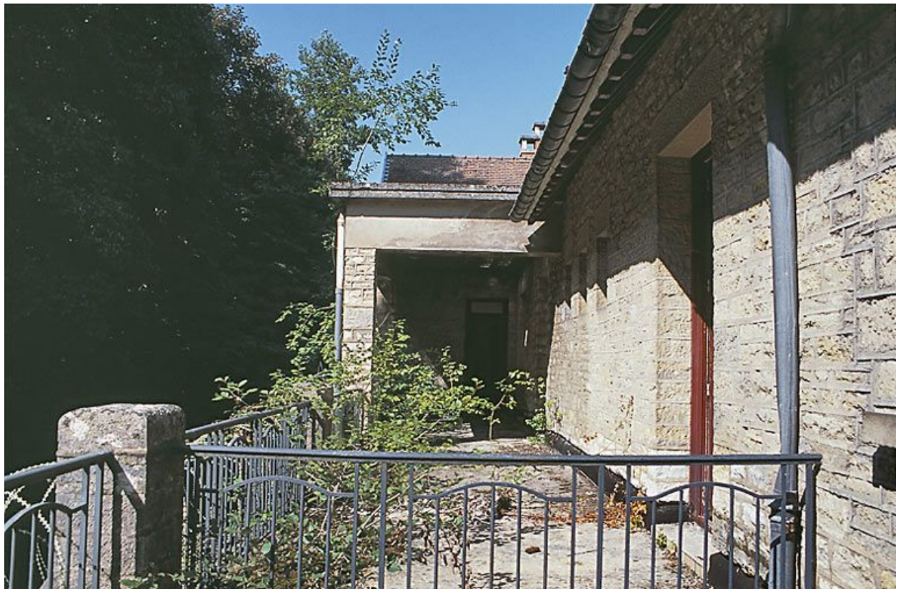
Bâtiment central, terrasses de la façade sud.
